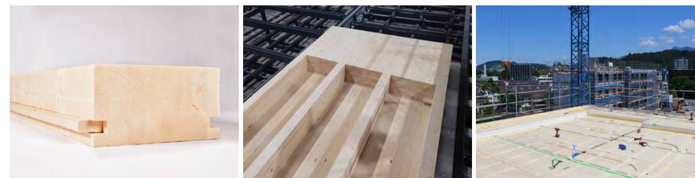
< Planchers MHP profilés et taillés en usine pour la construction de la nouvelle succursale Migros à Zweisimmen BE.
