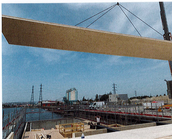
↑ Levée de la charpente.
