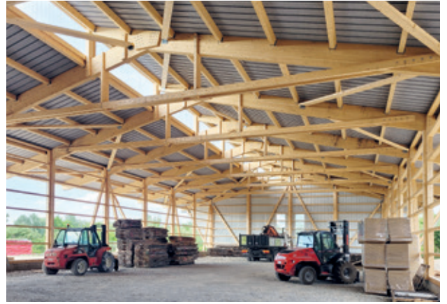
Halle industrielle, Bartenheim (F)
