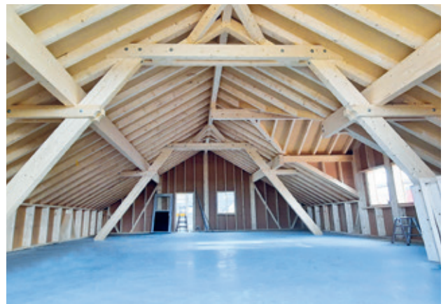
Charpente visible de maison individuelle, Rothenburg (CH)
