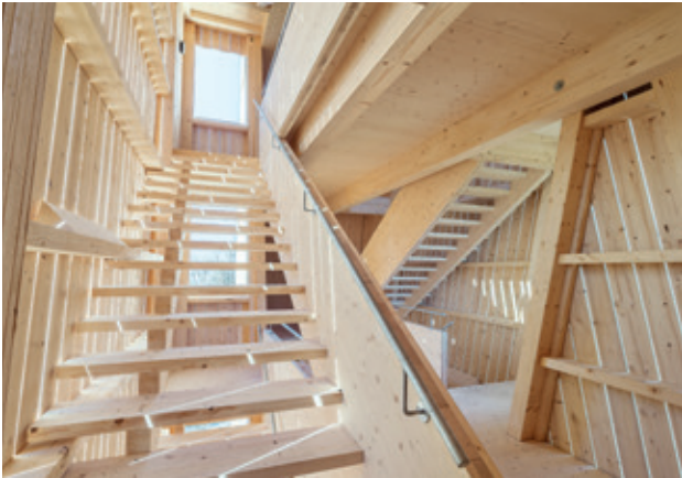
Vue intérieure de la Tour panoramique du zoo de Goldau (CH)
