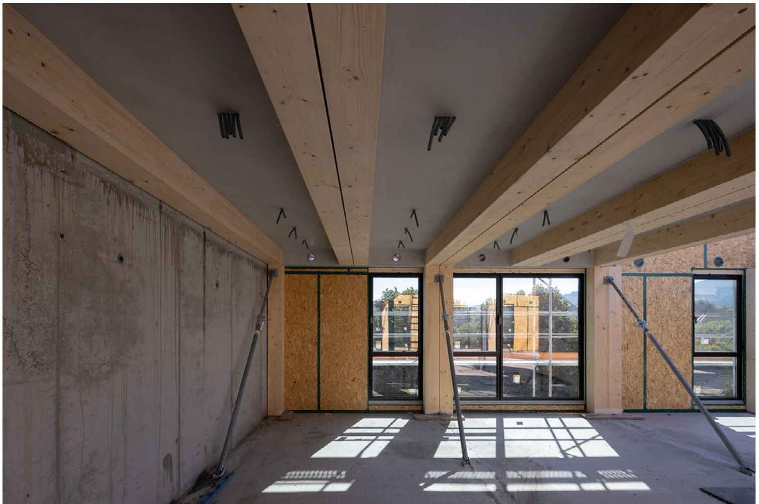
Die hybriden Bauteile Holz-Beton bei der Montage und nach der Montage.
