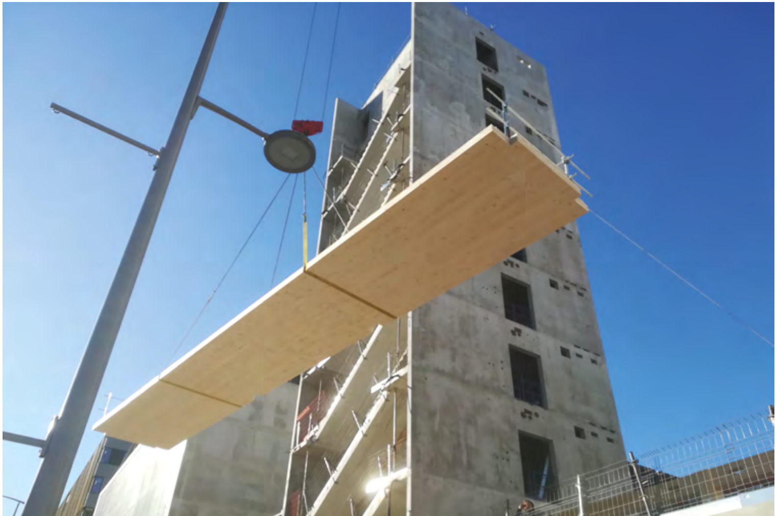
La fabrication d'éléments de plancher d'une longueur de 16,9m a permis un montage particulièrement rapide de cet immeuble de 35m de hauteur.
