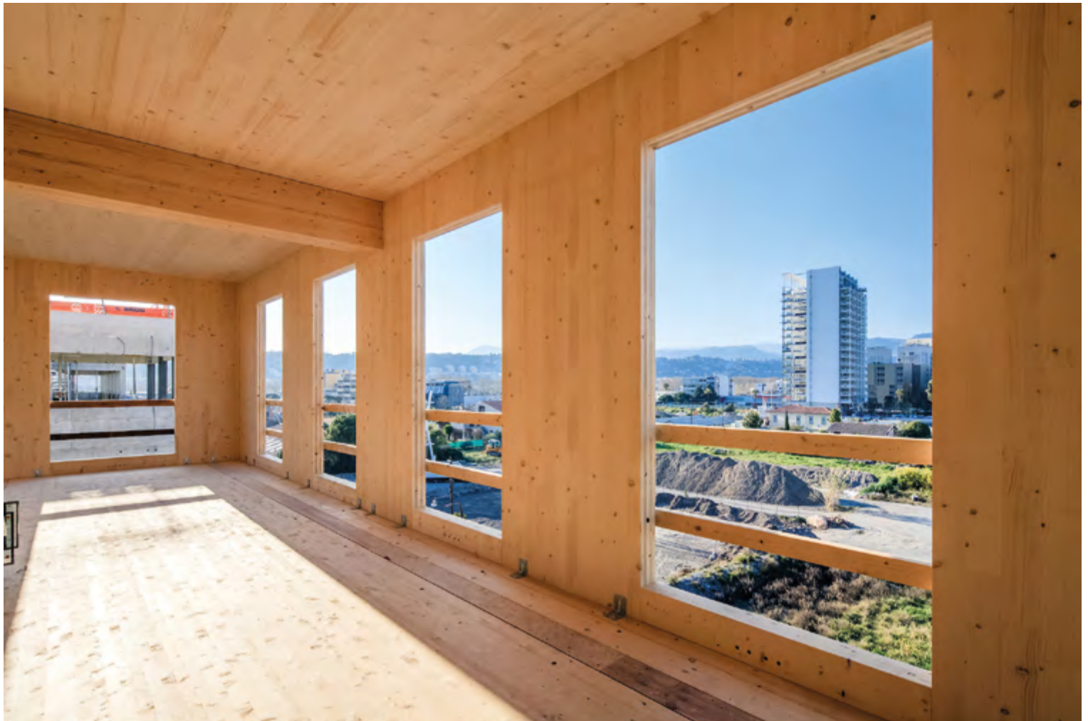
Près de 1300m 3 de CLT en bois local, en qualité visible, ont été fabriqués en France et livrés en 4 mois.
