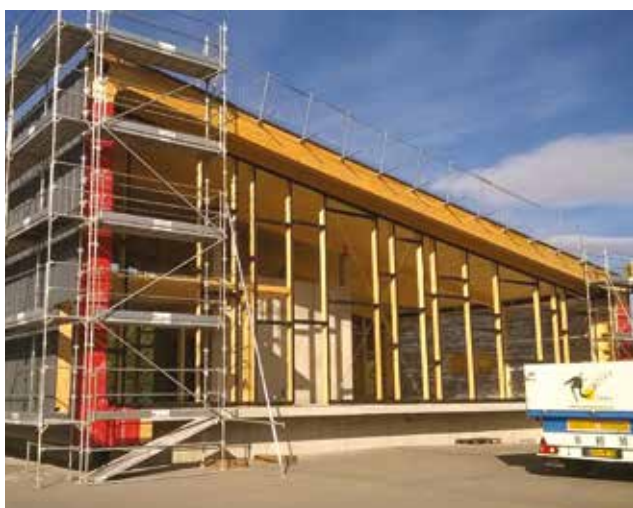
Bürogebäude mit innen sichtbaren GFP®-Platten (Réguisheim F)
