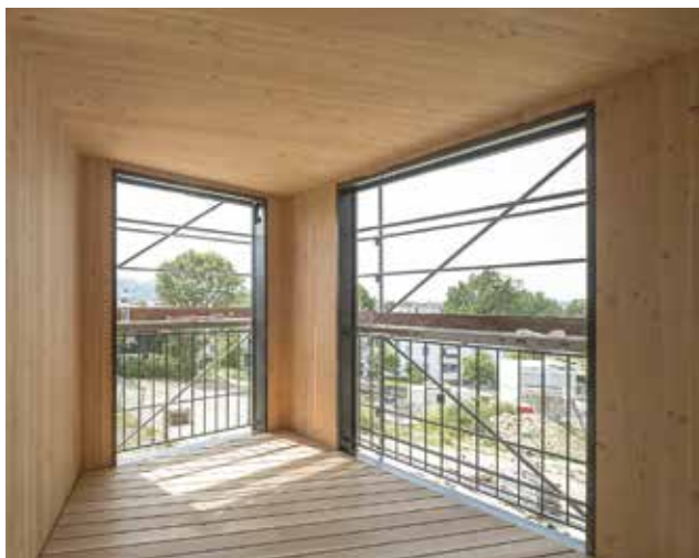
Terrassen mit GFP® aus Douglasie in einem 5-geschossigen Holzbau (Winterthur)
