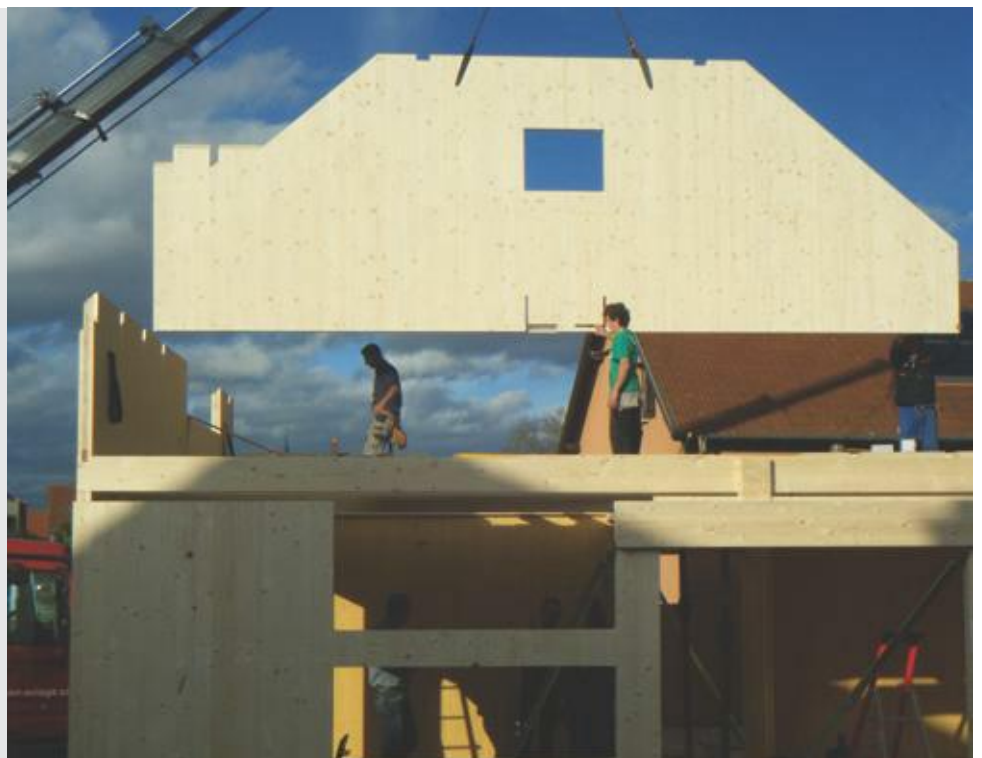
Montage d'un panneau (maison individuelle, Reguisheim)
