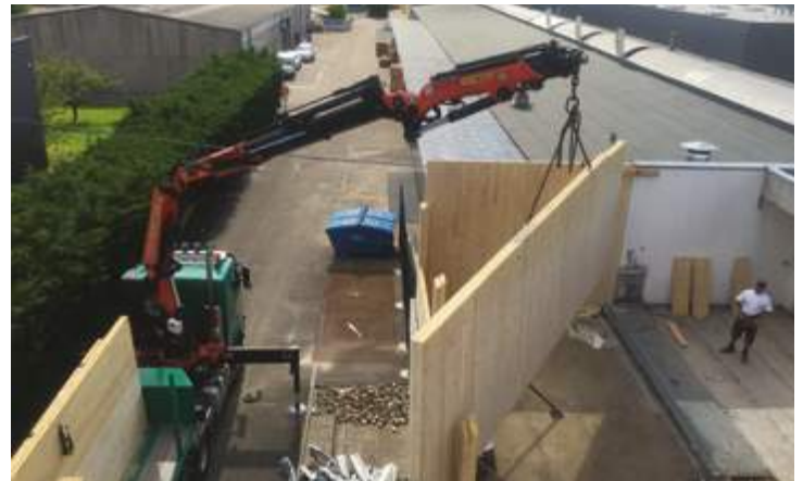
Surélévation d'un bâtiment (Wittenheim, France)
