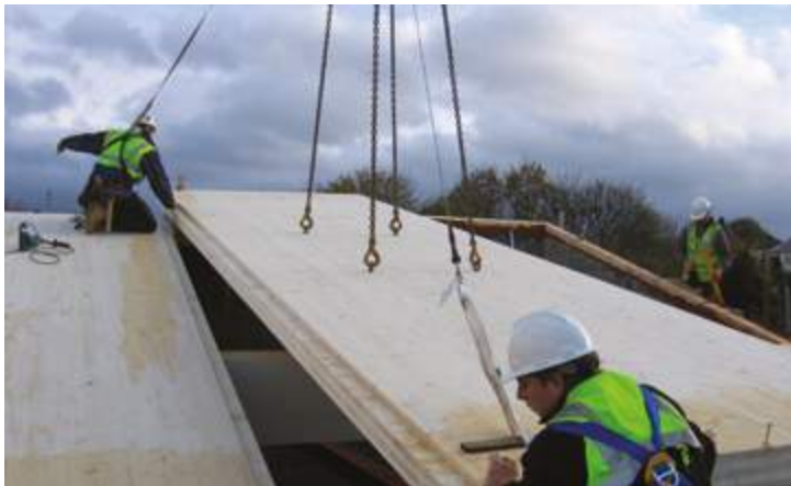
Montage d'une toiture (Lansdowne, Royaume-Uni)
